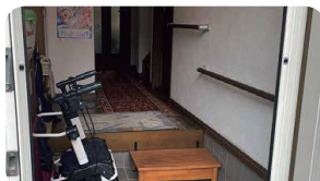
上がり框の上下の手すりが不連続で水平。動作に合っていない。
